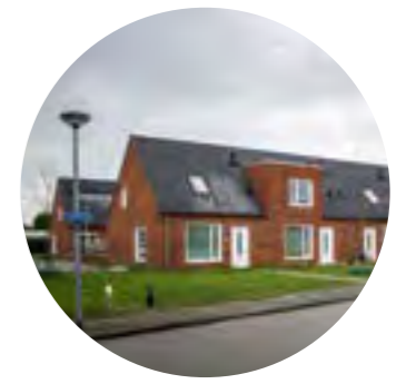
Woonbuurten met bevingsschade
