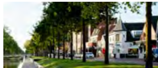
Onderdeel van het centrumplan is gevelherstel
