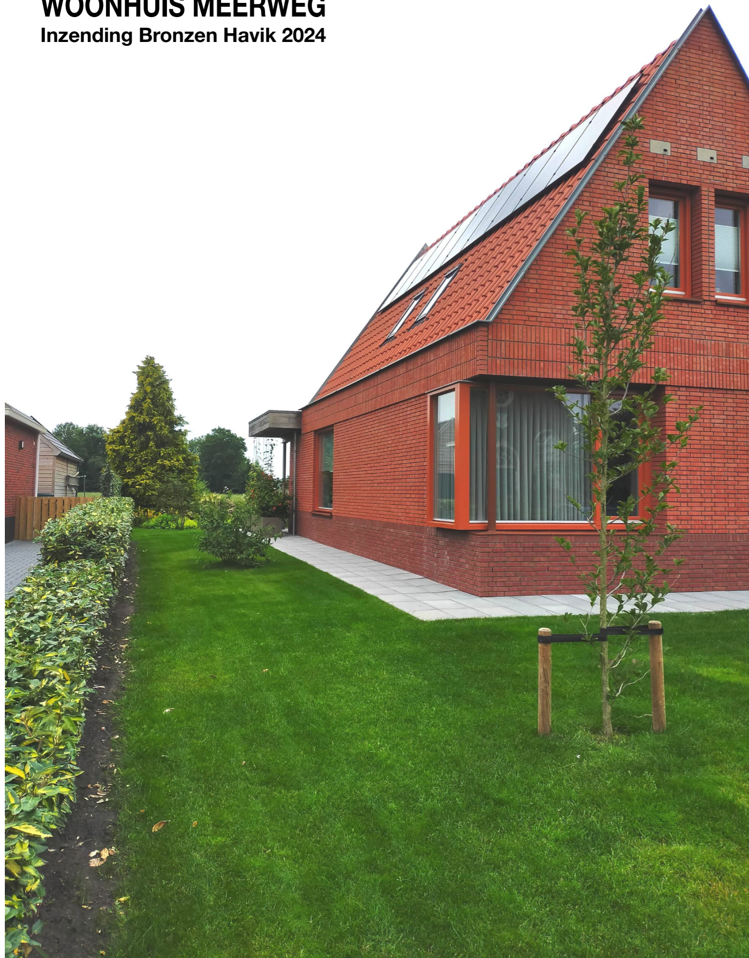
▲ De horizontale geleding in het metselwerk door trasraam en bovenplint van staand metselwerk verlagen optisch het geheel, waardoor het huis gevoelsmatig dichter bij het oorspronkelijke volume blijft. (Groninger) orangerode tinten in zowel metselwerk, pannen, kozijnen en de ronde kolom brengen eenheid in het geheel.
